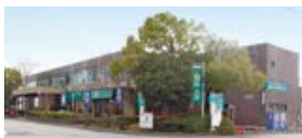
多治見給食センター外観
