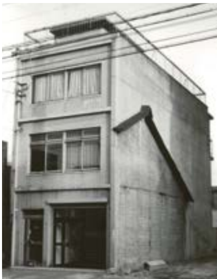
名古屋市守山区の日本社のあったビル
